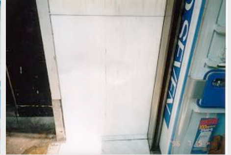
○飛散防止高圧洗浄機にて洗浄
