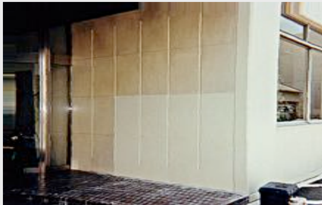
○ ライムストーン外部壁 20年 右下部が施工後
