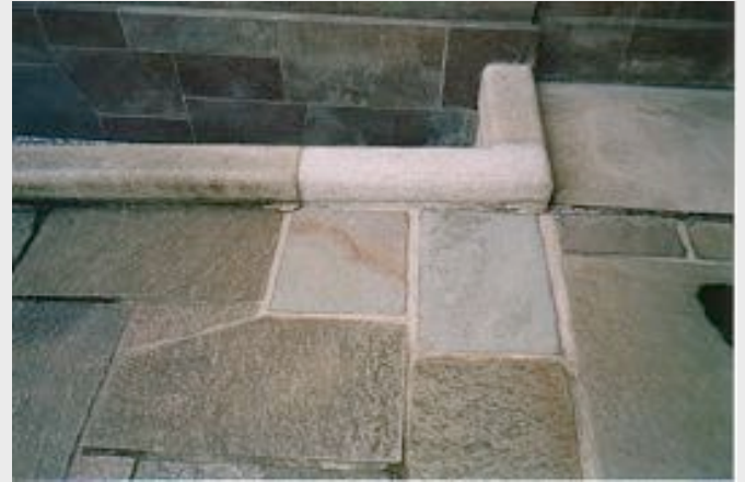
○中央部が施工後
