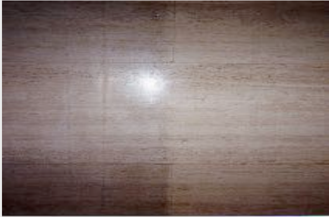
○トラパーチン内部壁 施工前→施工後
