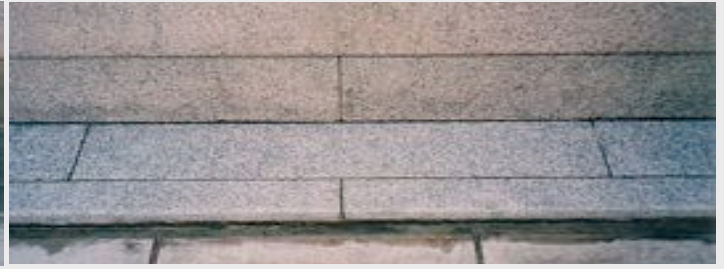
○施工後 (AD-1・AD-3・高圧洗浄)
