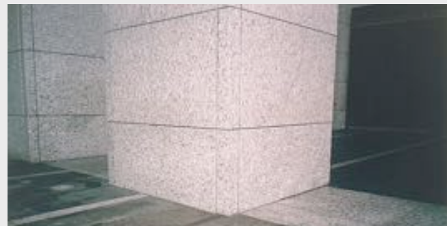
○施工後（AD-1・AD-2・AD-6・スチーム洗浄）
